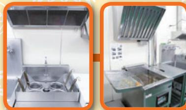
▲局所換気システムが導入され、効率的に適切な温湿度環境が維持されている
